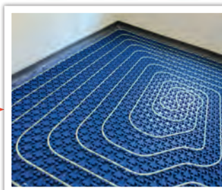
Fußbodenheizung
