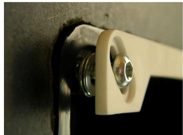
Zum Ausbauen der EAS (1) das mitgelieferte Werkzeug (2) oben zwischen Wand und Glasfront einschieben und mit leichtem Druck die Verriegelung lösen.
