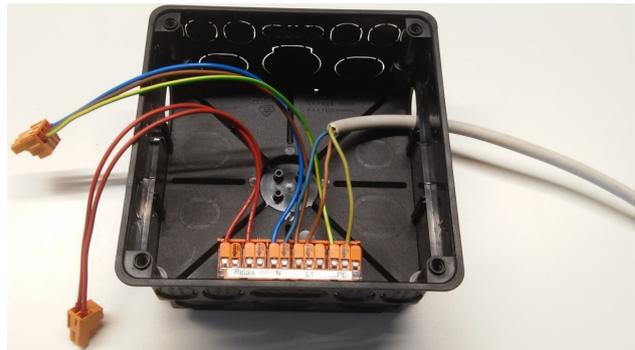
Abb. 3: Netzkabel angeschlossen
