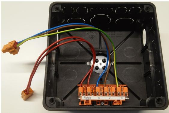
Abb. 2: Anschlussset in den Unterputzkasten eingeschraubt
