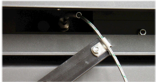
Abbildung 27: Kabel an Führungsschiene
