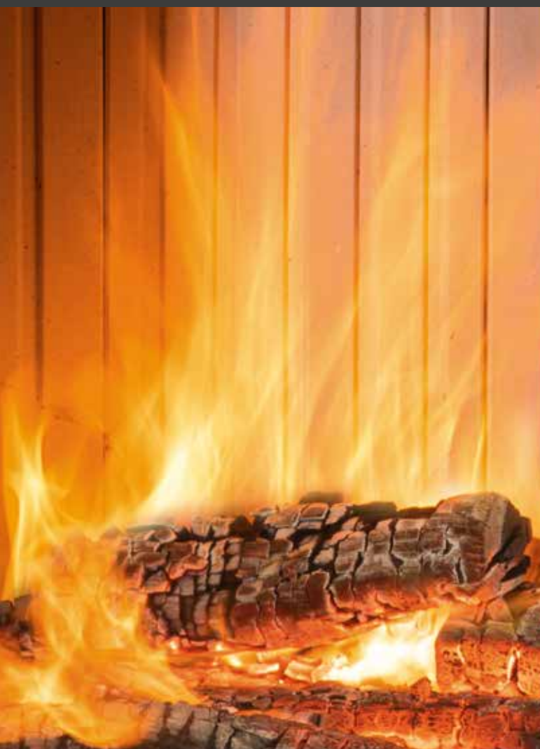
Revêtement du foyer en chamotte
