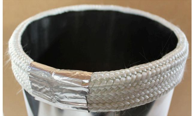
Das Rauchrohr mit Dichtung in den Rauchgasanschluß stecken und rundum mit Faserfilz abdichten.
