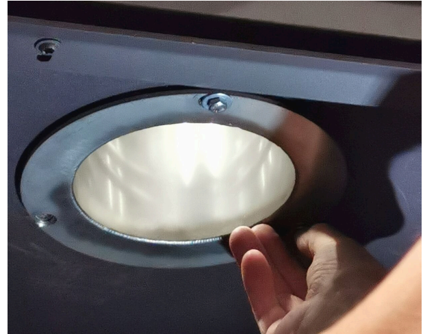
Rauchgasabgang anbringen und mit drei Schrauben von innen anschrauben
