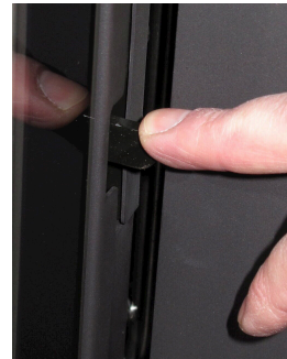
Abb. 4: Öffnen der Eck-Feuerungstür rechts zur Reinigung
