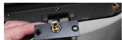
Abb. 55: Einsetzen des Türkontaktschalters in Quersteg Front
