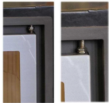
Im. 8: Loosening the door stop
